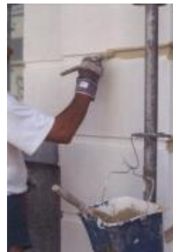
Photo Dr M-B. Cleenewerck Port de gants protecteurs lors de la mise en peintures d'une façade (travaux de réfection).
